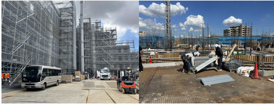
图 2 木内建设施工现场
